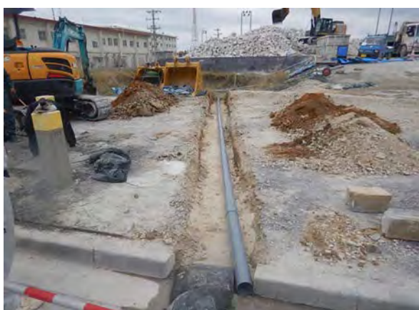
(仮設排水路の設置)
