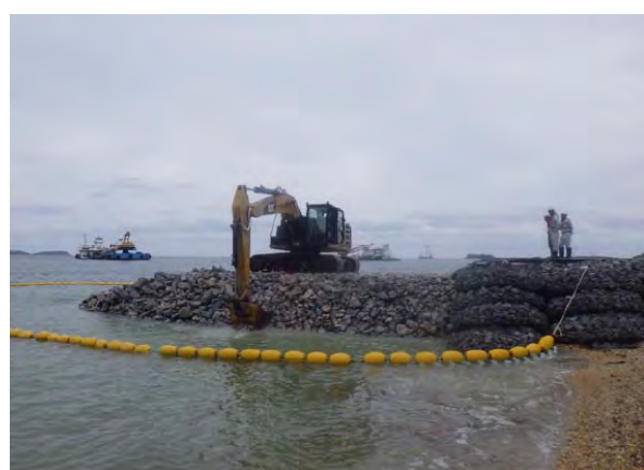
（傾斜堤護岸 K-9）
