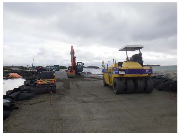
図-4.1.4 仮設道路工事の実施状況
