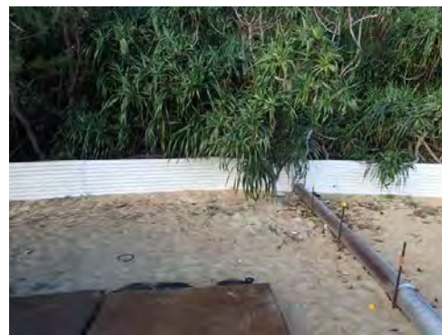
進入防止柵の周辺状況
