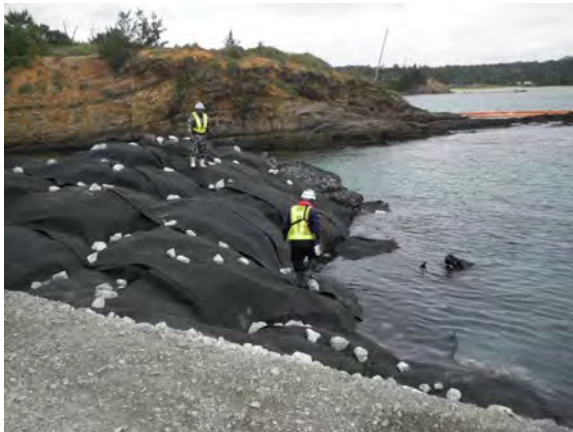
(粉じん発生源対策：シートによる防塵・散水)
