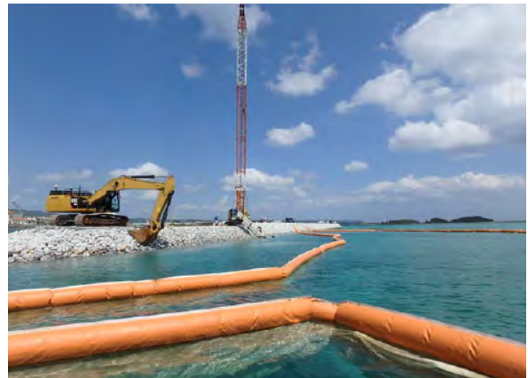
(傾斜堤護岸 K-4)
