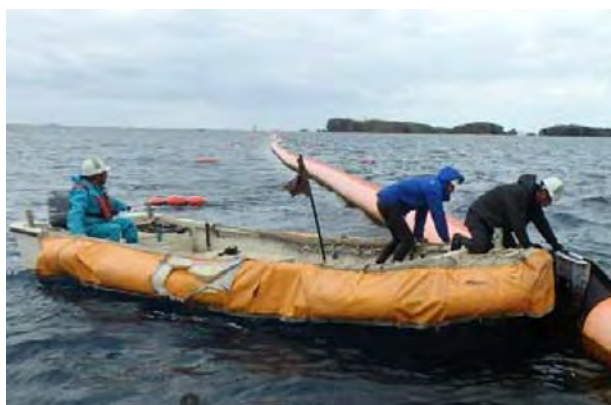
(汚濁防止膜の設置・使用、損傷の有無の確認)
