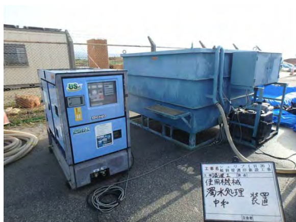
(濁水処理プラントの設置)
