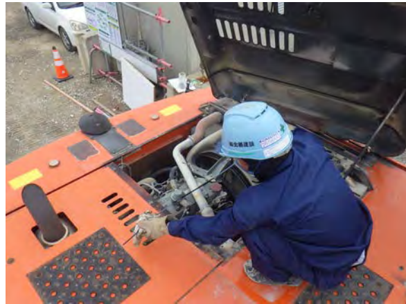
(建設機械の整備・点検)
