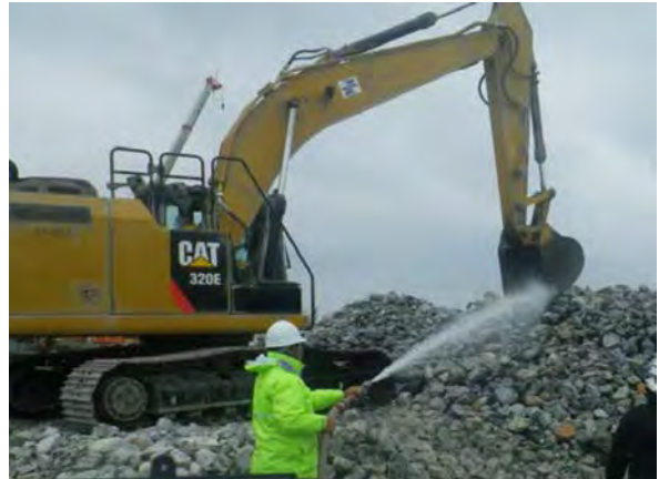
(粉じん発生源対策：シートによる防塵・散水)
