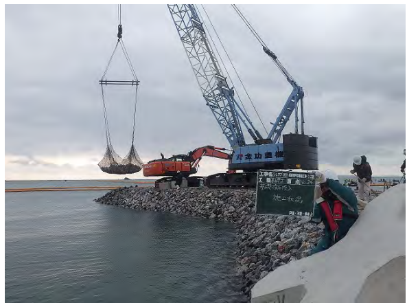
(傾斜堤護岸 K-2)
