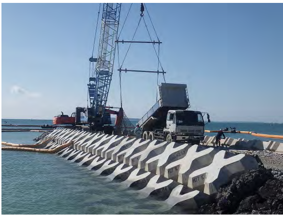
(傾斜堤護岸 K-1)
