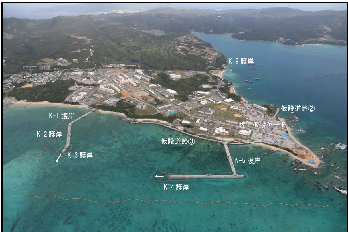
工事の実施状況（平成 30 年 3 月末時点）
