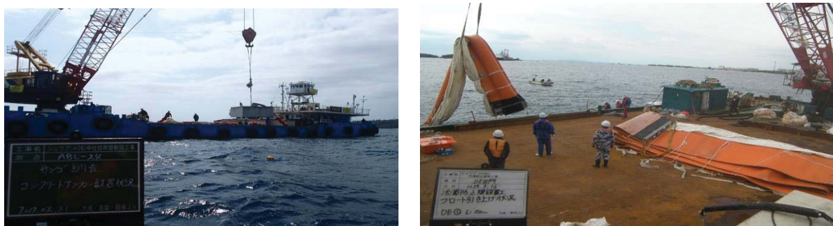
図-4.1.2 汚濁防止膜設置の実施状況
