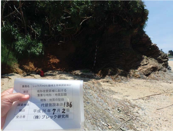
写真 (No.136①) 露頭がある南西向きの海蝕崖。 非対称性褶曲。 写真左側は崖面が一部崩落している。
