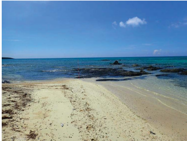
写真 (No.132④) 波蝕棚。 堤防と波蝕棚の間に砂が堆積し、トンボロ状に陸と繋がっている。
