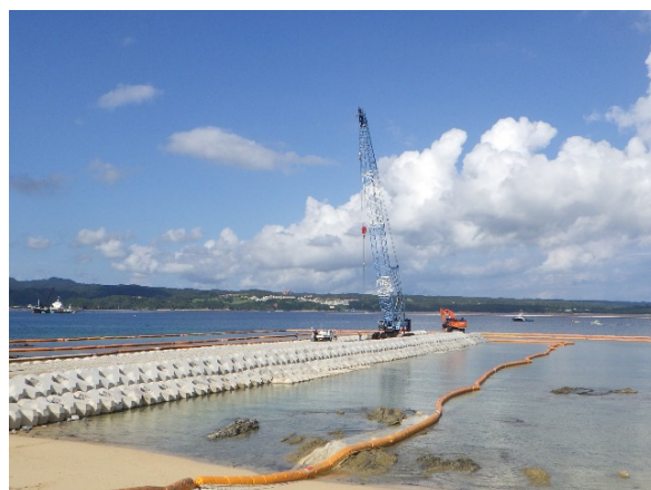
(中仕切護岸 N-2)
