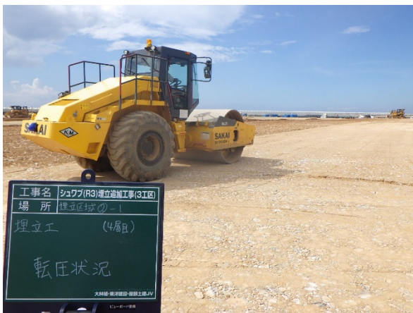
(粉じん発生源対策：転圧)
