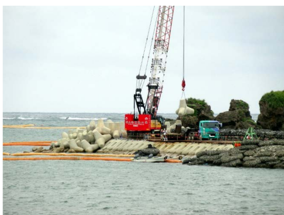
(傾斜堤護岸 K-8)
