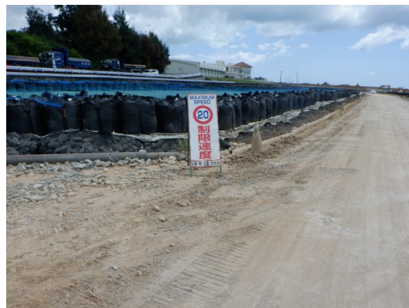
(規制速度表示板の設置)
