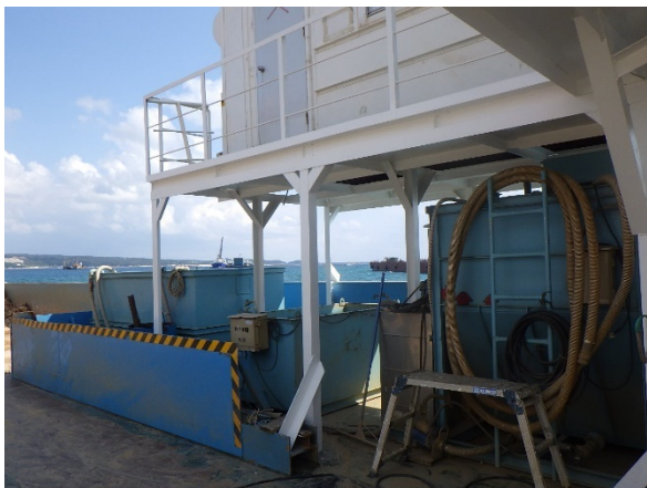
(濁水処理プラントの設置)
