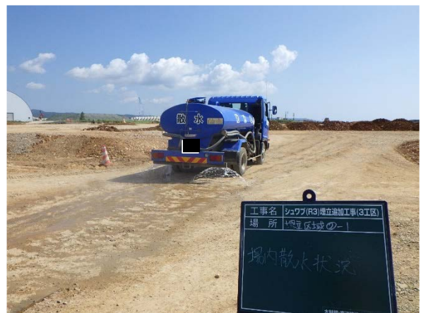
(粉じん発生源対策：散水)
