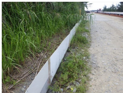
【進入防止柵の周辺状況】
