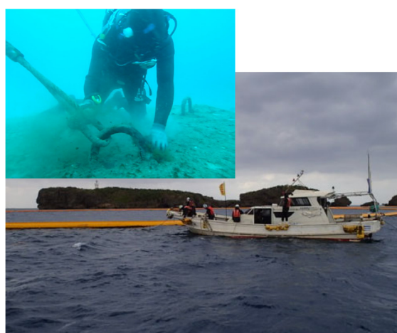
(浮沈式垂下型の汚濁防止膜の点検作業)
