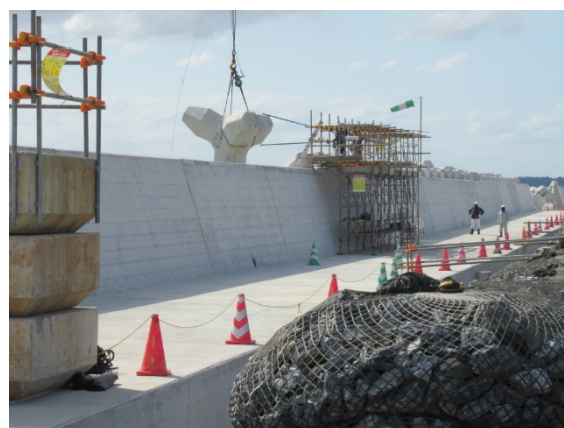
(傾斜堤護岸 K-4)
