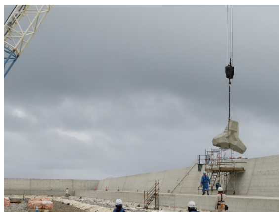
(傾斜堤護岸 K-3)
