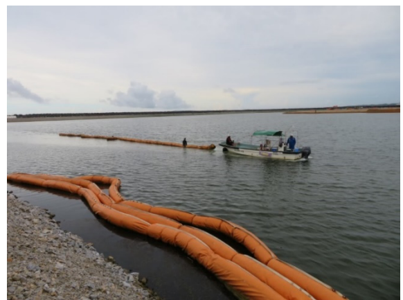
【工事の状況(汚濁防止膜移設・撤去)】
