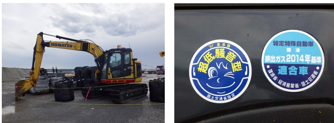
(排出ガス対策型の建設機械の使用)
