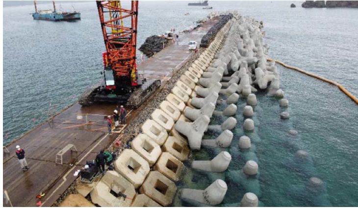
(傾斜堤護岸 K-8)
