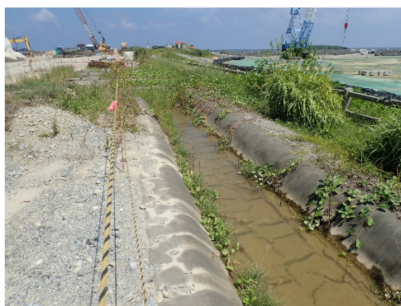
(仮設排水路の設置)
