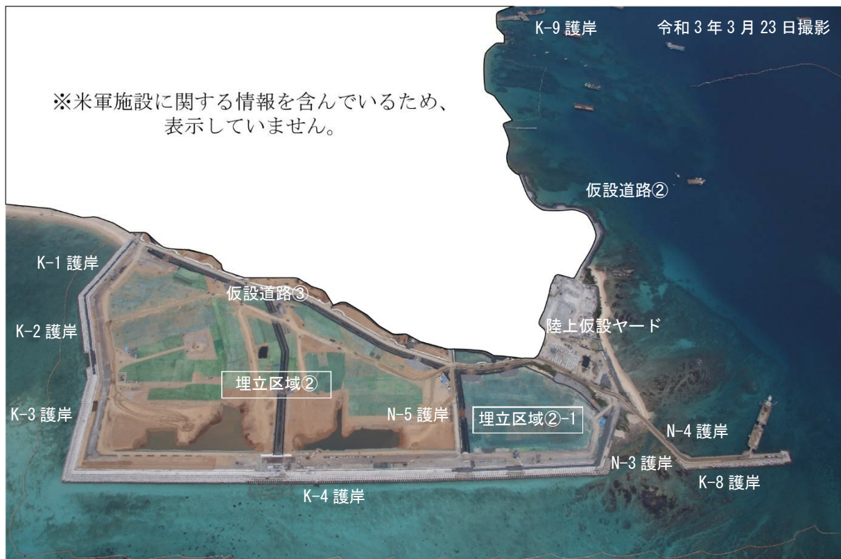
工事の実施状況（令和 3 年 3 月 23 日時点）
