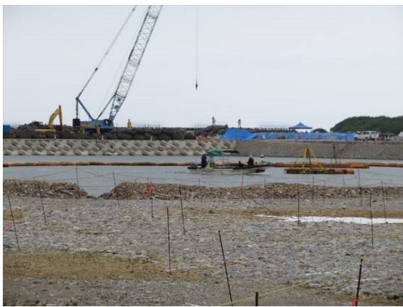
【工事の状況(汚水管延長作業)】
