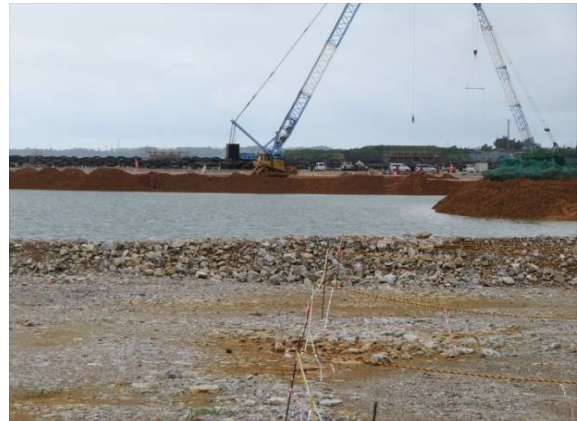
【工事の状況(鉄筋・型枠組立)】
