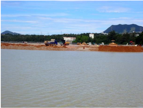
【工事の状況(埋立土砂投入)】
