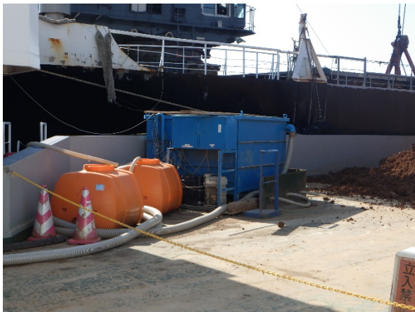
(濁水処理プラントの設置)
