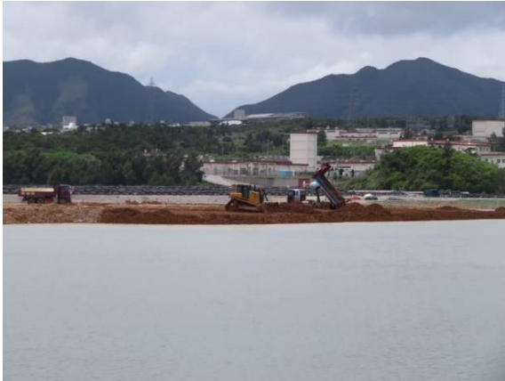
【工事の状況(埋立土砂投入)】
