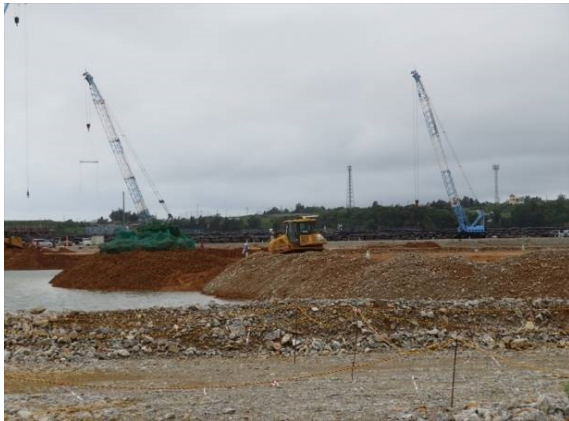
【工事の状況(埋立土砂投入)】
