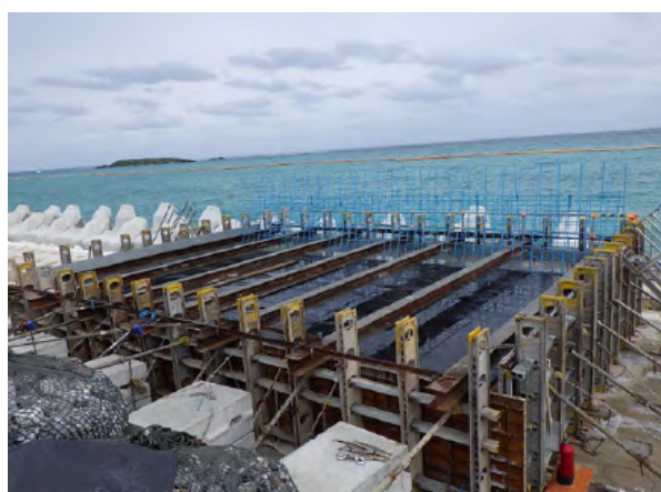
(アクアマット敷設による養生水の節水)
