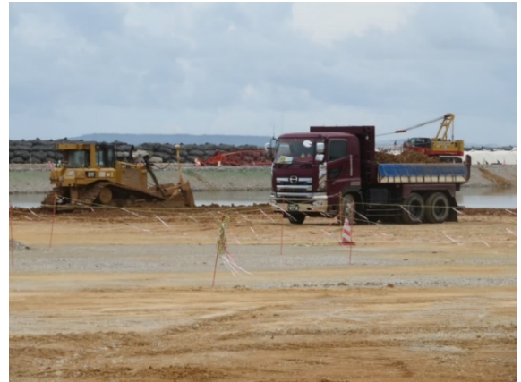
【工事の状況(埋立土砂投入)】
