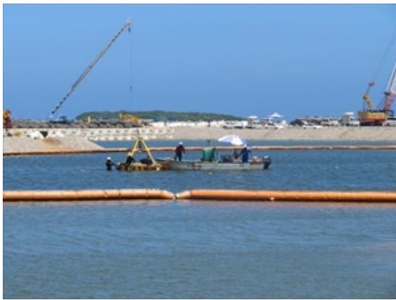
【工事の状況(汚水管延長作業)】
