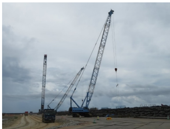
【工事の状況(鉄筋・型枠組立)】
