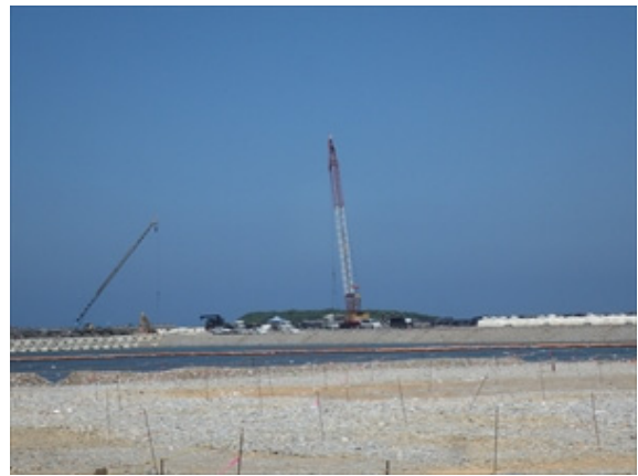
【工事の状況(遮水シート・袋材設置作業)】
