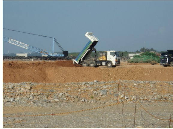
【工事の状況(埋立土砂投入)】
