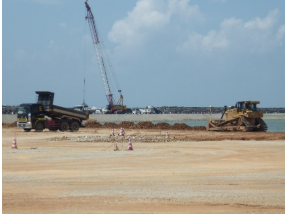
【工事の状況(埋立土砂投入)】
