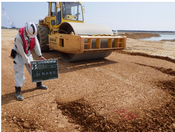
(粉じん発生源対策：転圧)
