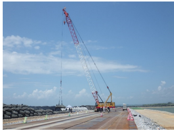
【工事の状況(防潮工事 遮水シート・袋材設置作業)】
