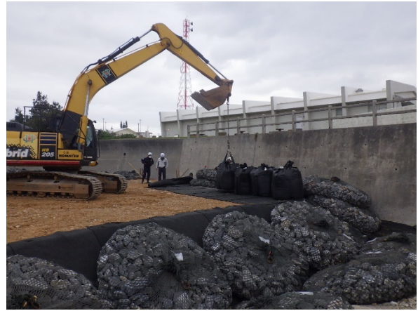
(台風対策：袋材の設置)
