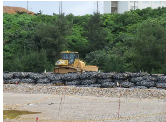
【工事の状況(仮設道路の穴埋め作業)】
