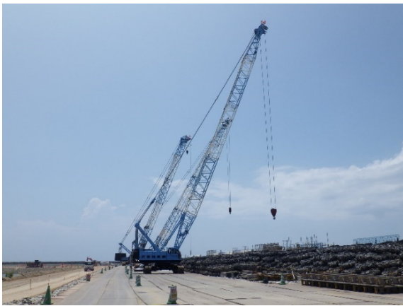
【工事の状況(鉄筋・型枠組立)】
