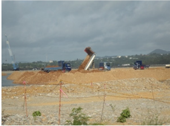
【工事の状況(埋立土砂投入)】
