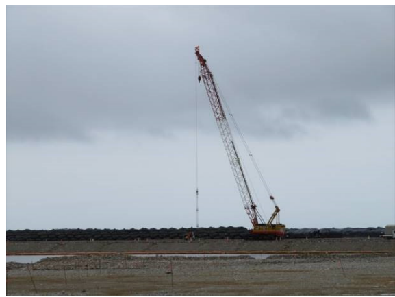
【工事の状況(遮水シート・袋材設置)】
