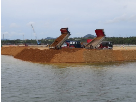
【工事の状況(埋立土砂投入)】
