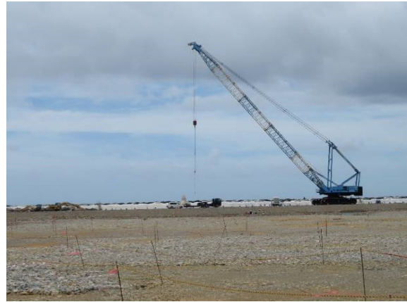
【工事の状況(消波ブロックの設置)】
