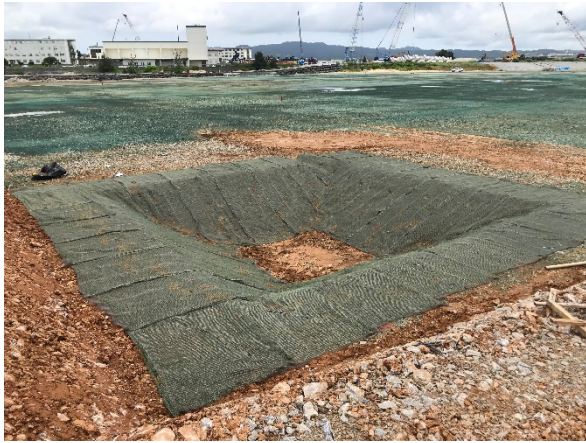
(土砂溜柵の設置)
