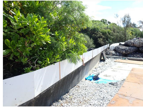
【進入防止柵の周辺状況】
