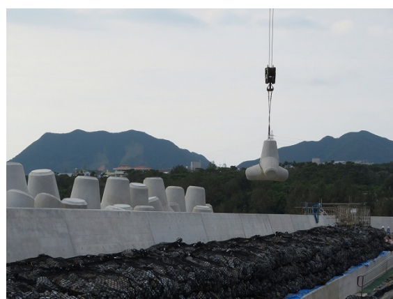
(傾斜堤護岸 K-2)
