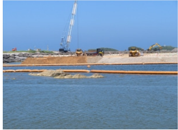
【工事の状況(埋立土砂盛土)】
