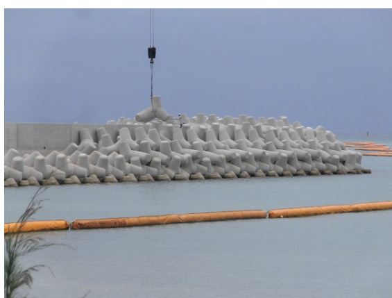
(傾斜堤護岸 K-1)
