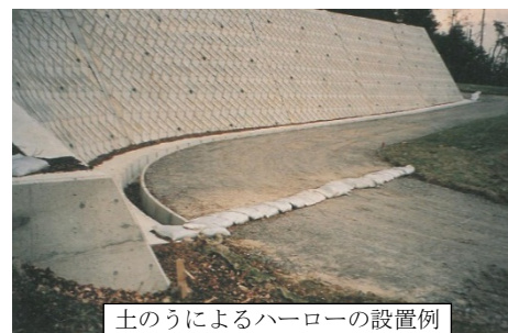
図-6.7.3.1.4 赤土等流出防止対策(緊急対策)の例
