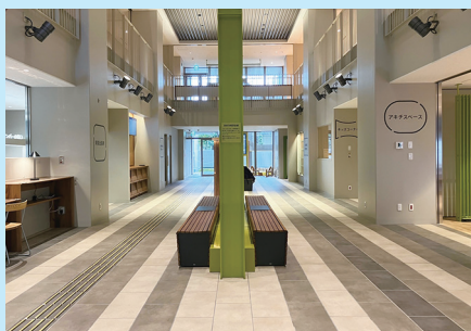
●中央通路● 地中熱を利用した空調設備を採用
