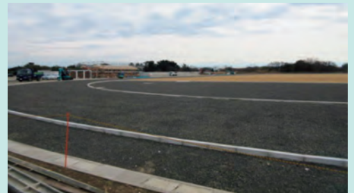
建設中の陸上競技場(31.2 撮影)
