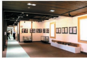
総漆喰塗りの内壁
