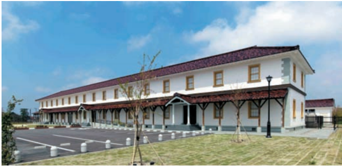
総漆喰塗りの外壁
