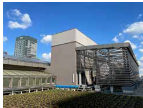
厚生棟(屋上緑化)
