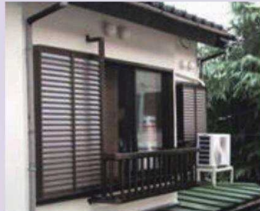
住宅防音工事施工後
