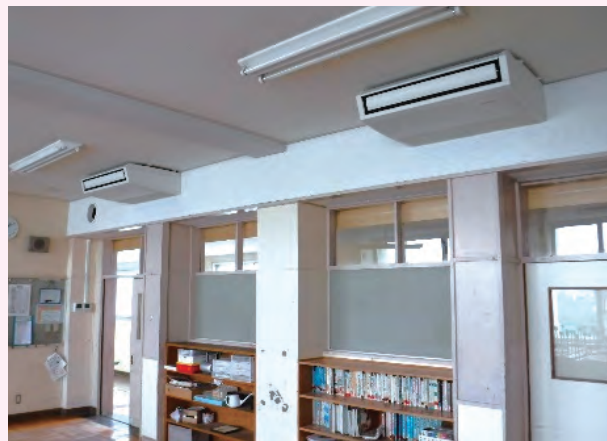
防音機能復旧工事後の写真
