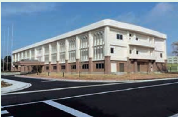
【庁舎外観南側】
