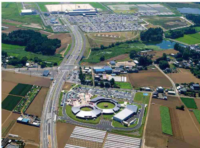
茨城空港（上）と「空のえき そ・ら・ら」（下）
