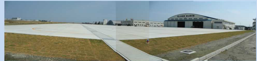
駐機場・格納庫（北徳島駐屯地）
