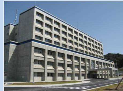
隊庁舎（高知駐屯地）
