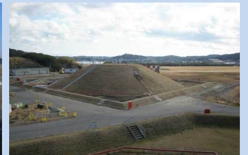
燃料タンク（館山航空基地）
