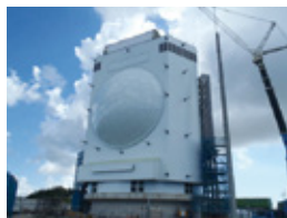
レーダー施設
