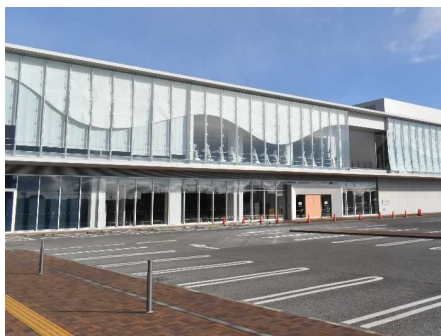
運動施設（体育館）
