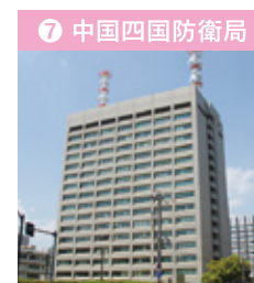
広島合同庁舎4号館 (広島市) 管轄区域/鳥取県・島根県・岡山県・広島県・山口県・徳島県・香川県・愛媛県・高知県
