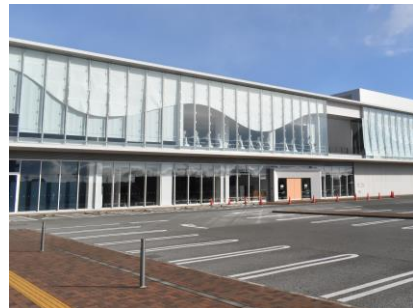
運動施設（体育館）
