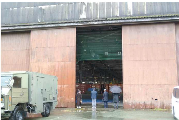
▲建物解体予定のNo.20補給廠（昭和18年竣工）の視察を行う委員の方々
