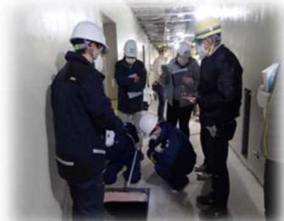
床下ピット内部をチェックしています。
