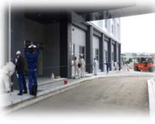
建物の出来高（寸法）をチェックしています。
