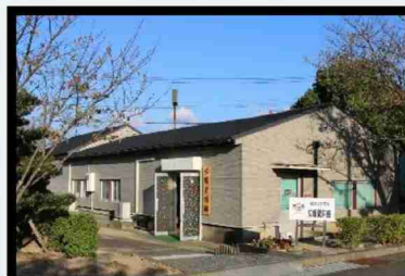
駐屯地資料館
