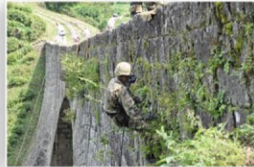
「通潤橋」除草作業
