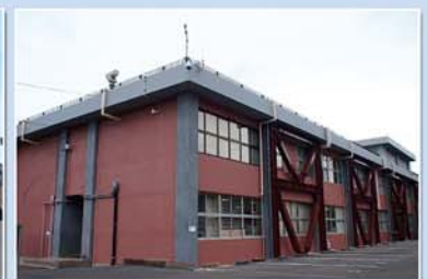
■ 本部庁舎改修後（平成26年3月撮影）
