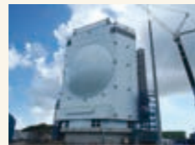
レーダー施設
