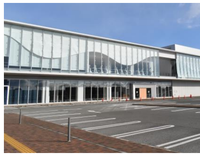
運動施設（体育館）
