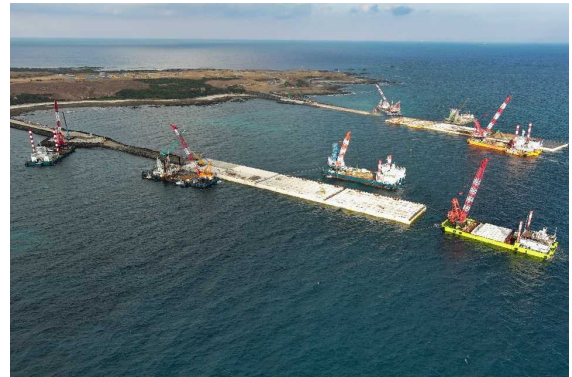
仮設棧橋工事
