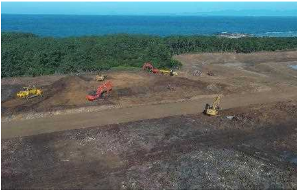
滑走路 造成工事
