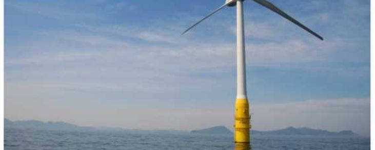
国内で初めて商用化された浮体式洋上風力発電の風車（崎山沖）
