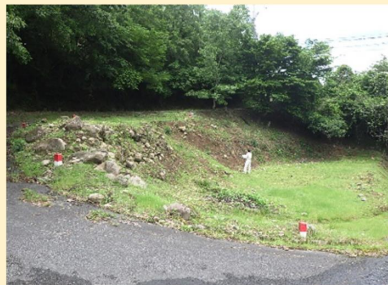
大雨の後の見回り
