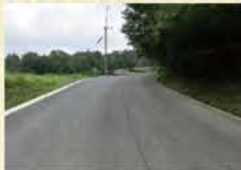
障害防止工事(道路改修)
