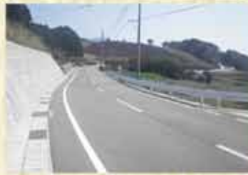
民生安定施設(道路改修)
