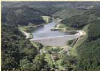
障害防止工事(農業用施設)
