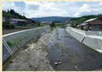
障害防止工事(河川改修)
