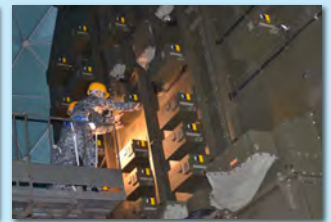
レーダー整備
