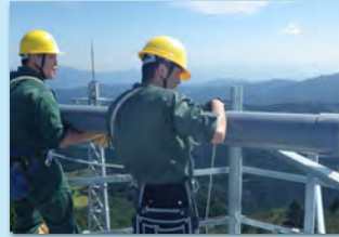
対空無線機アンテナ設置
