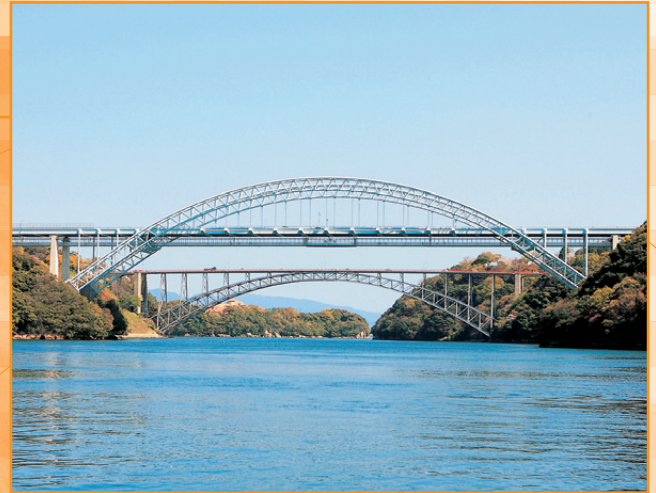
新西海橋(手前)、西海橋(奥) (長崎県西海市)
