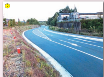
道路改修後の上田崎線
