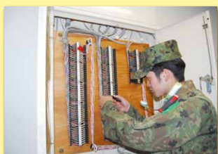
端子盤の点検
