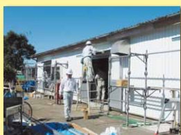
駐屯地施設の外壁工事
