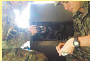
電気点検実施中
