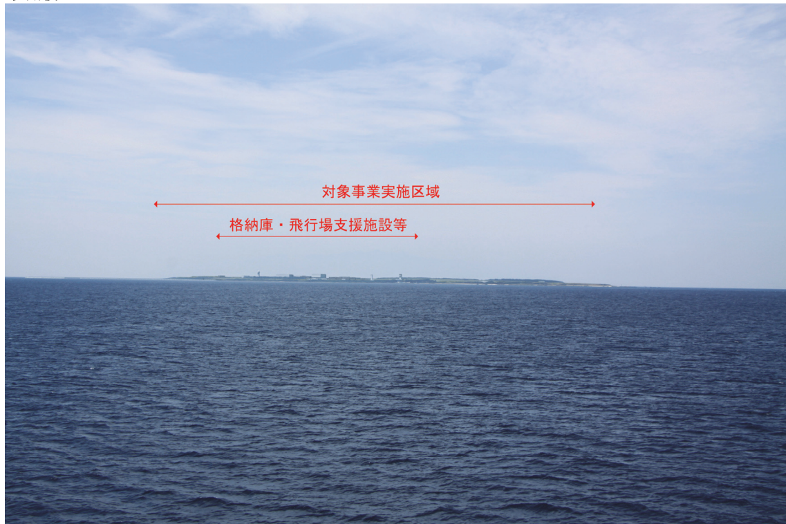
図-6.17.8(4) 主要な眺望景観の変化（No.4 フェリー航路（鹿児島～西之表））
