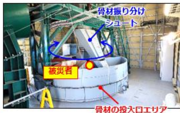
現場状況写真
