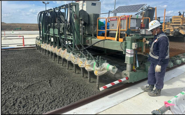
滑走路 舗装工事
