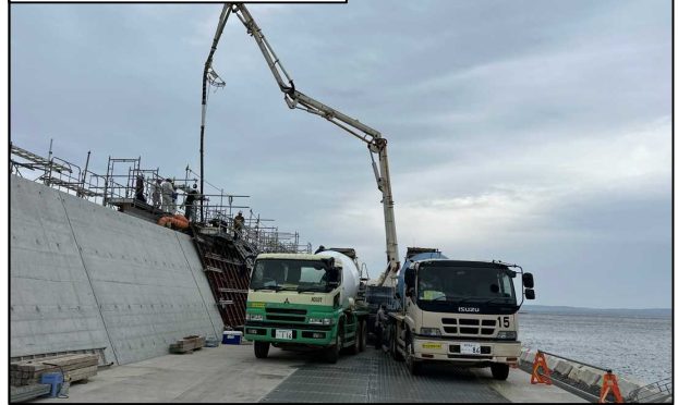
係留施設等工事
