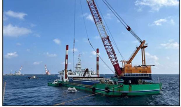
係留施設等工事
