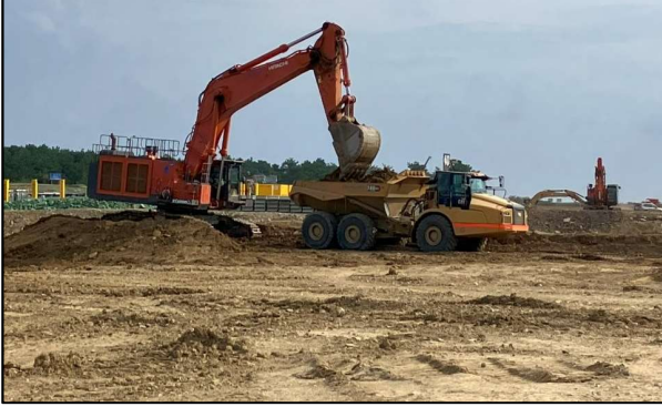
滑走路 造成工事
