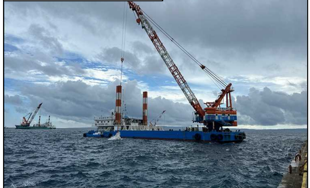
係留施設等工事
