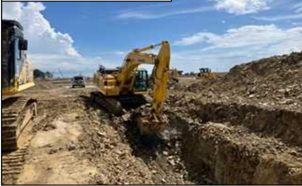
駐機場等施設 造成工事
