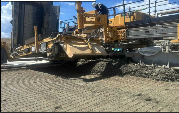
滑走路 舗装工事
