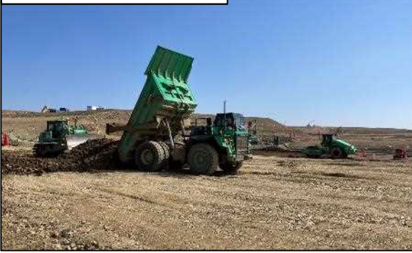
滑走路 造成工事
