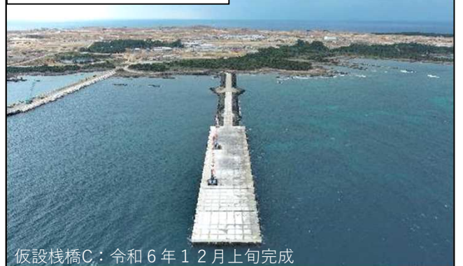
仮設棧橋工事
