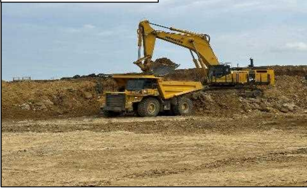
滑走路 造成工事
