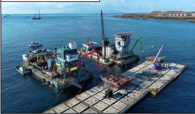
係留施設等工事
