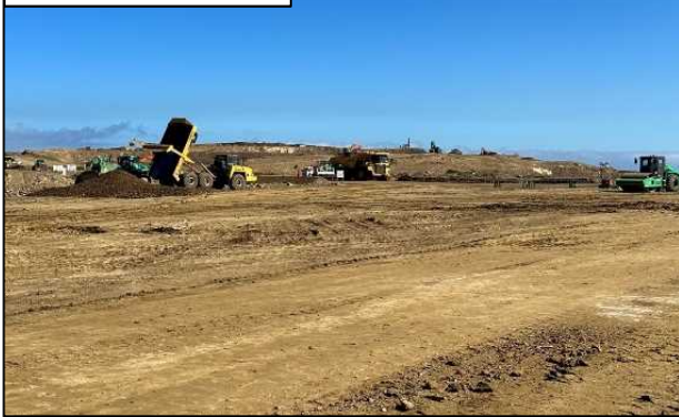
滑走路 造成工事
