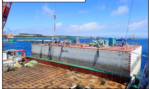
係留施設工事
