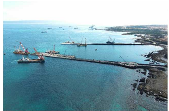
仮設棧橋工事
