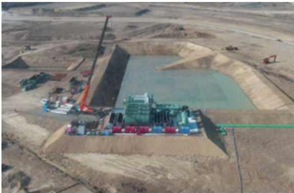
滑走路 造成工事
