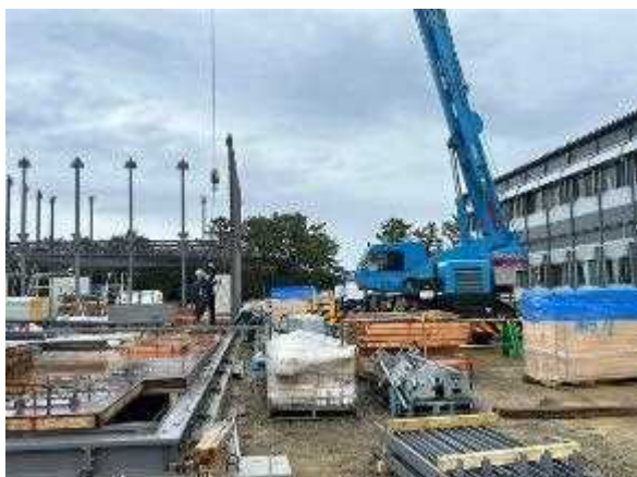
仮設宿舎工事
