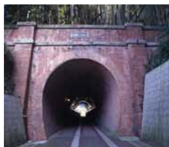
北吸トンネル (きたすい)
