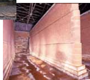
旧北吸浄水場配水池施設 (きたすい)
