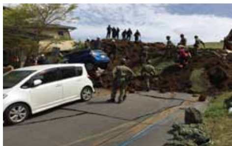
土砂災害の状況を確認
