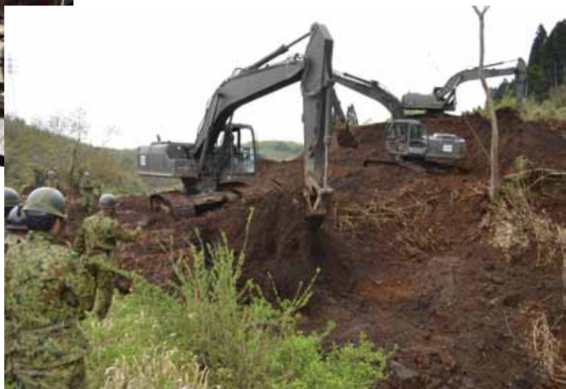
土砂が堆積した河川を浚渫
