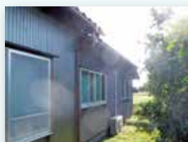
防音工事施工前
