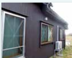
防音工事施工後
