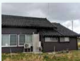
防音工事施工後
