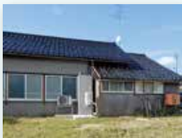
防音工事施工前
