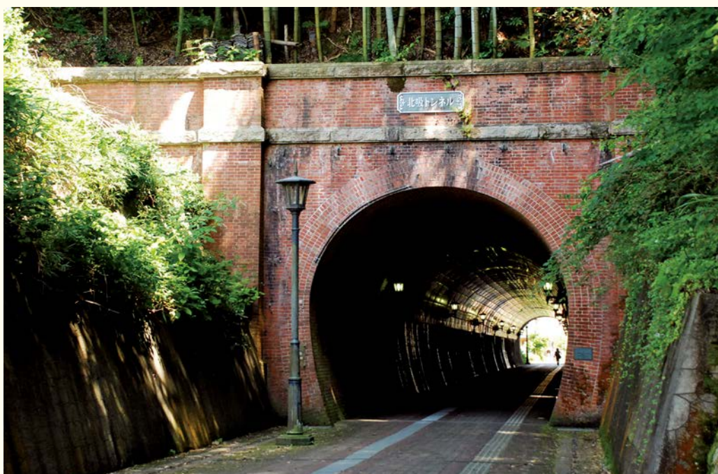
（赤れんが建造物の1つ、旧海軍施設への引き込み線用の「北吸トンネル」）
