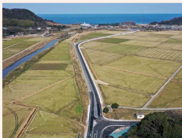
府道浜丹後線（宮バイパス）
