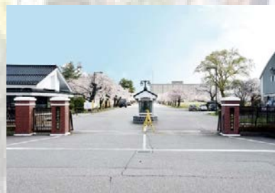
令和2年 現在の金沢駐屯地
